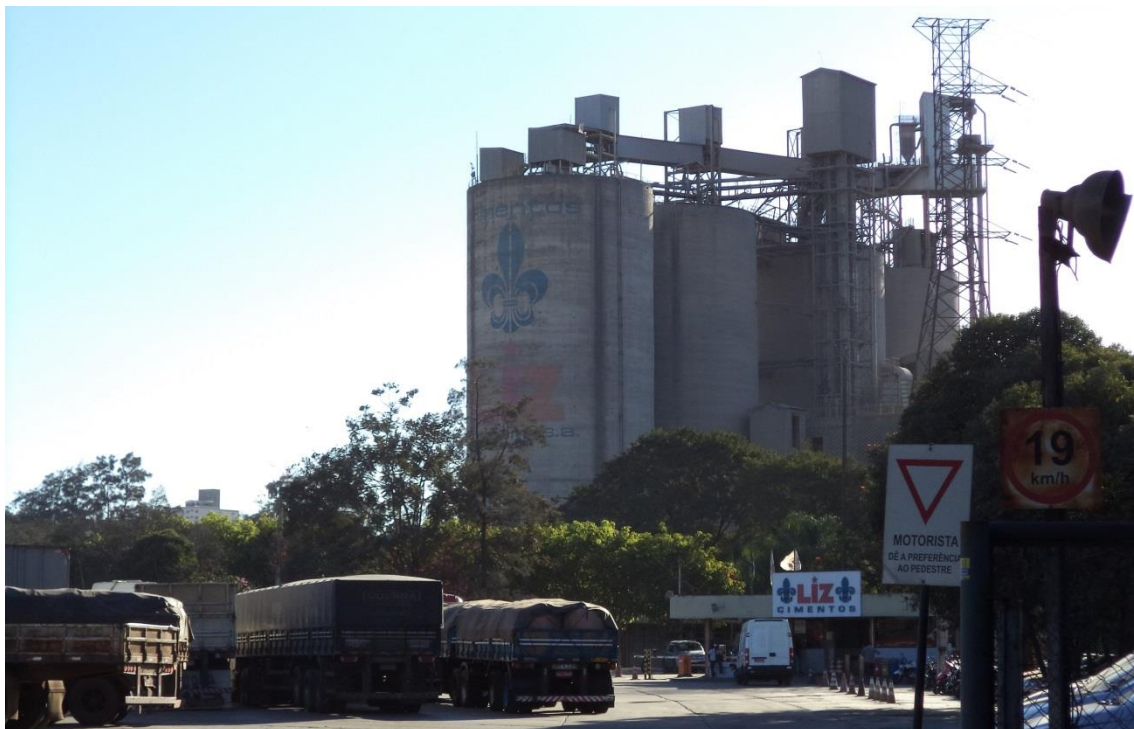
Pátio de entrada da Empresa de Cimentos Liz no centro do Município de Vespasiano (MG) Fonte: Arquivo pessoal (2015)
