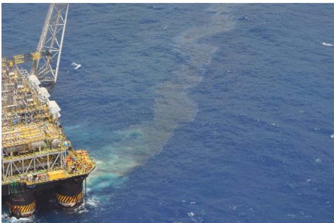
Figura 86: Imagem aérea de descarte de água produzida gerando mancha iridescente na água. Plataforma P-40, em 28/11/2012, na bacia de Campos. Fonte: registros fotográficos de acompanhamento de simulado de emergência, foto da analista ambiental Ana Paula Fernandez (IBAMA).
